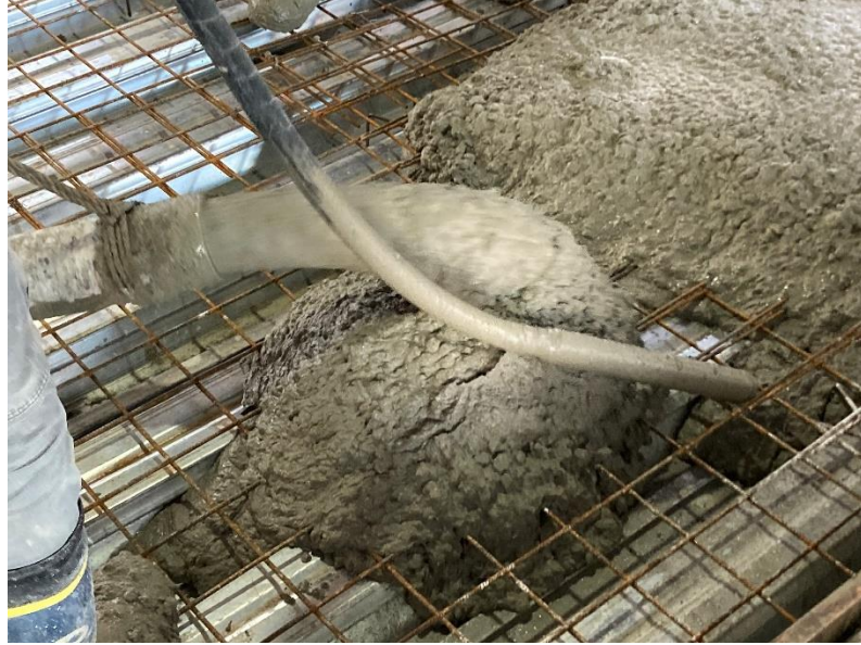
▲コンクリート打設状況
