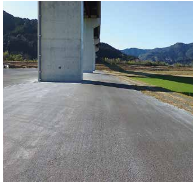
写真 8 : 高架下防草対策
