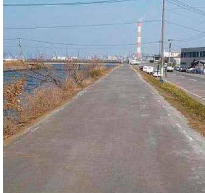
写真 4 : 河川護岸天端管理道路
