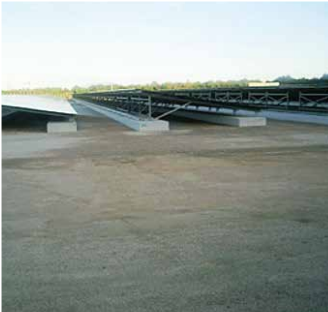
写真 7 : ソーラー発電所防草対策
