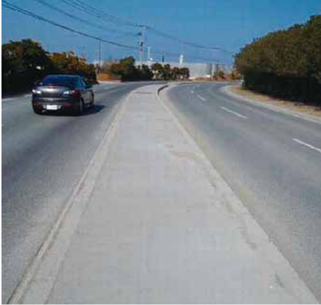
写真 3 : 中央分離帯防草対策
